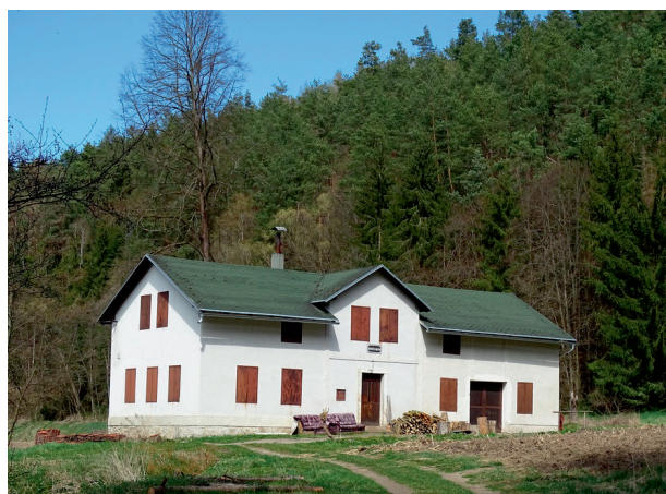
Obr. 14: Budova bývalého Růtova mlýna
