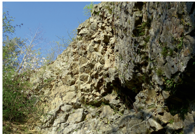
Obr. 2: Lomová stěna sz. od vrcholu odkryla sloupcovitou odlučnost čediče. Ve štěrbinách rostou hojně kapradiny (např. sleziník červený).
