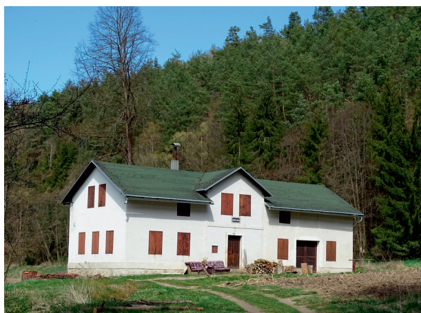
Obr. 14: Budova bývalého Růtova mlýna
